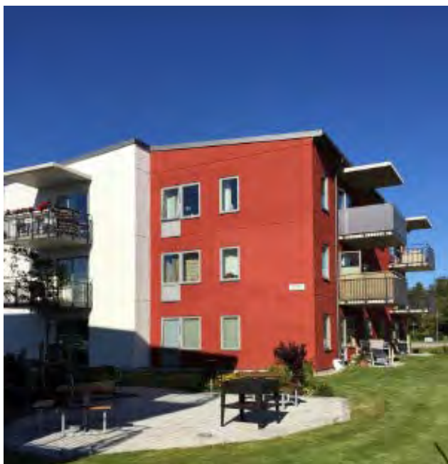
I maj 2015 stod Kombohuset på Syster Ebbas väg i Kållekärr klara för inflyttning. På uteplatsen mellan husen finns grillmöjligheter. Foto: TBAB.
