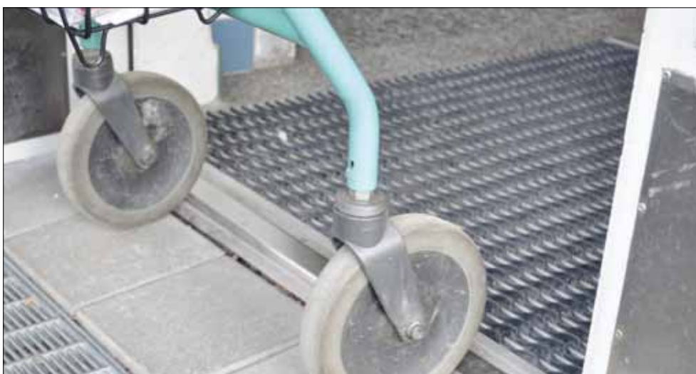
Små trösklar försvårar framkomligheten. Foto: Lindahl.
