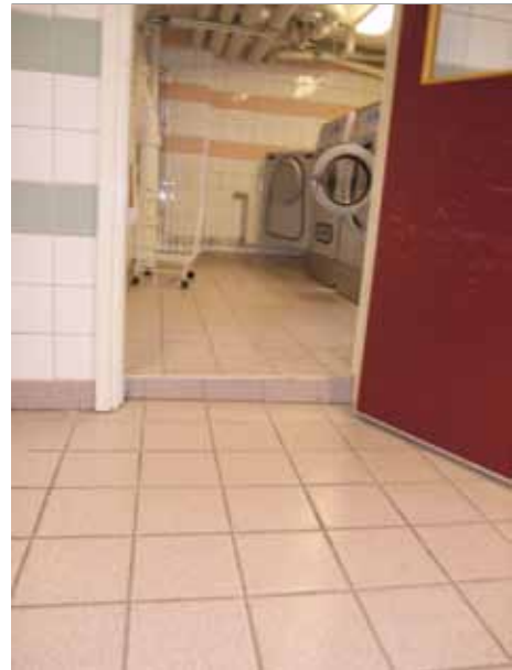
Ingång till ett av tvättrummen. Foto: Martini.
