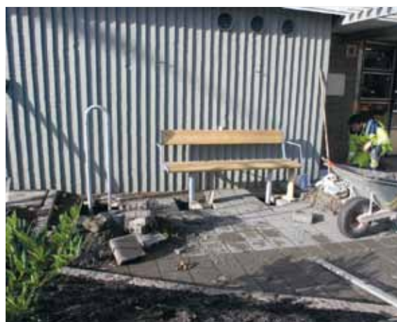
Entré under ombyggnation. Foto: Martini.
