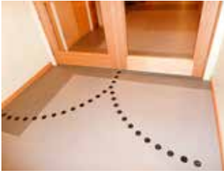
Prickar som märker ut hur dörrar öppnas när automatiska dörröppnare används.
