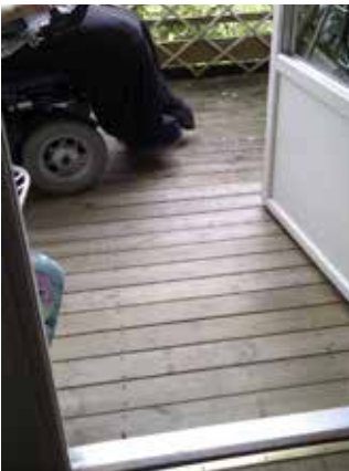
Tröskelanpassning ut till altan/balkong. Många äldre kommer inte ut och då är balkongen/altanen ändå en möjlighet att få "komma ut" lite grand. Bilder: Lisbeth Lindahl.
